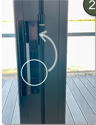
Verriegelung nach oben klappen
